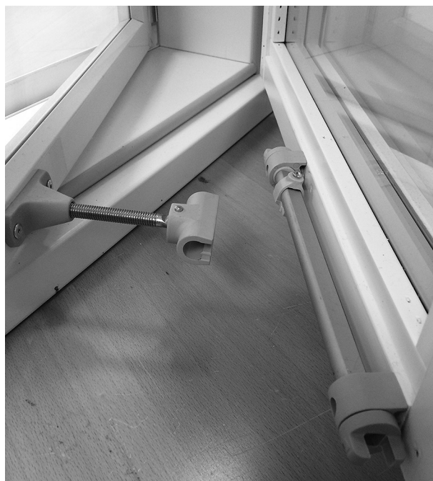
Liukukiskon lukitusvipu vaaka-asennossa (vapautettuna).
