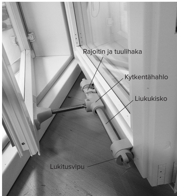
Liukukiskon lukitusvipu pystyasennossa (kytkettynä).
